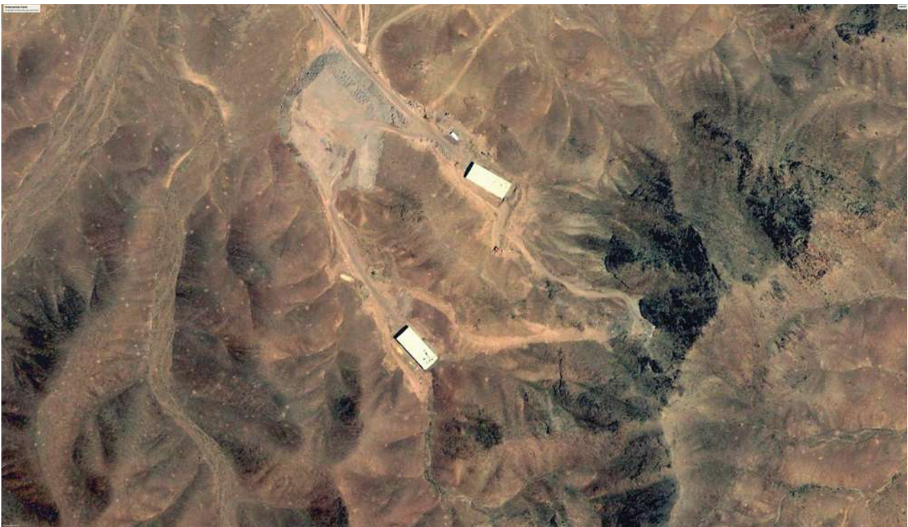
Abbildung 12: Im Juni 2004 verdeckten Gebäude die Eingänge zu dem in Bau befindlichen Tunnelsystem der Anlage Fordo. (Quelle: Google Earth)
